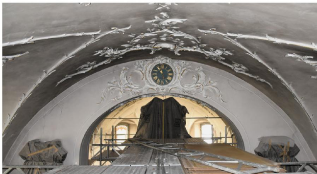
Blick von der Arbeitsplattform unter dem Gewölbe hin zum verschobenen, zu seinem Schutz jedoch gut eingehüllten Altar.
