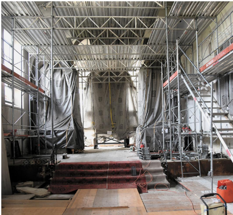
Heute vor genau sieben Monaten starteten die Bauarbeiten in der Kirche des Klosters Wonnenstein.
