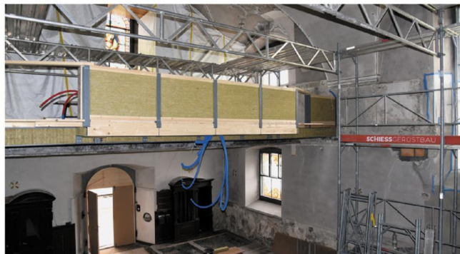
Die Empore über dem Eingang ist bereits verkürzt. Ihre Position ab der Erweiterung von 1928/29 zeigen Spuren an der Wand.
