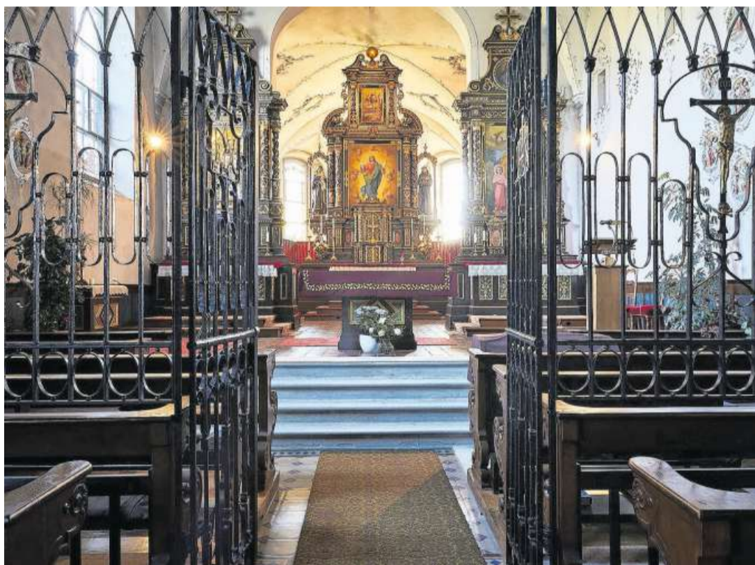
Die Klosterkirche wurde zum letzten Mal vor hundert Jahren renoviert.
